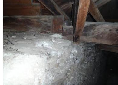
Bundesdenkmalamt ein Statiker beauftragt diese zu untersuchen. Im Zuge der Untersuchungen wurde festgestellt, dass der Zugring, welcher die Kuppel statisch stützt, gebrochen ist. Da nun die statische Sicherheit der Kuppel bei einer entsprechenden Schneelast nicht mehr gegeben ist, mussten unverzüglich Sofortmaßnahmen eingeleitet werden um einen möglichen Schaden an dem einmaligen Kulturjuwel abzuwenden.
